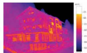
Termosnímek s testo ScaleAssist
