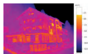
Termosnímek s testo ScaleAssist
