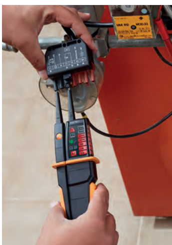
Kontrola napätia na pripájacom konektore vykurovacieho zariadenia pomocou testo 750.
