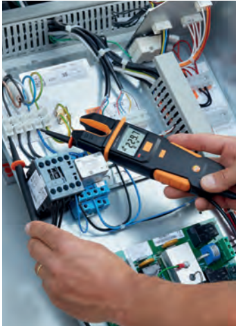
Meranie napätia na kompresore prístrojom testo 755.
