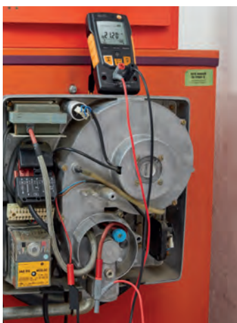
Meranie ionizačného prúdu s testo 760.
